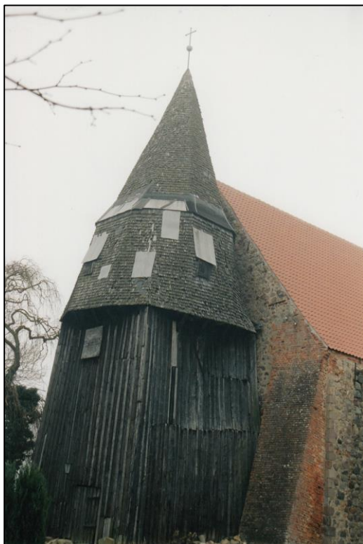
Der Kirchturm vor der Sanierung, 1997 (8)
